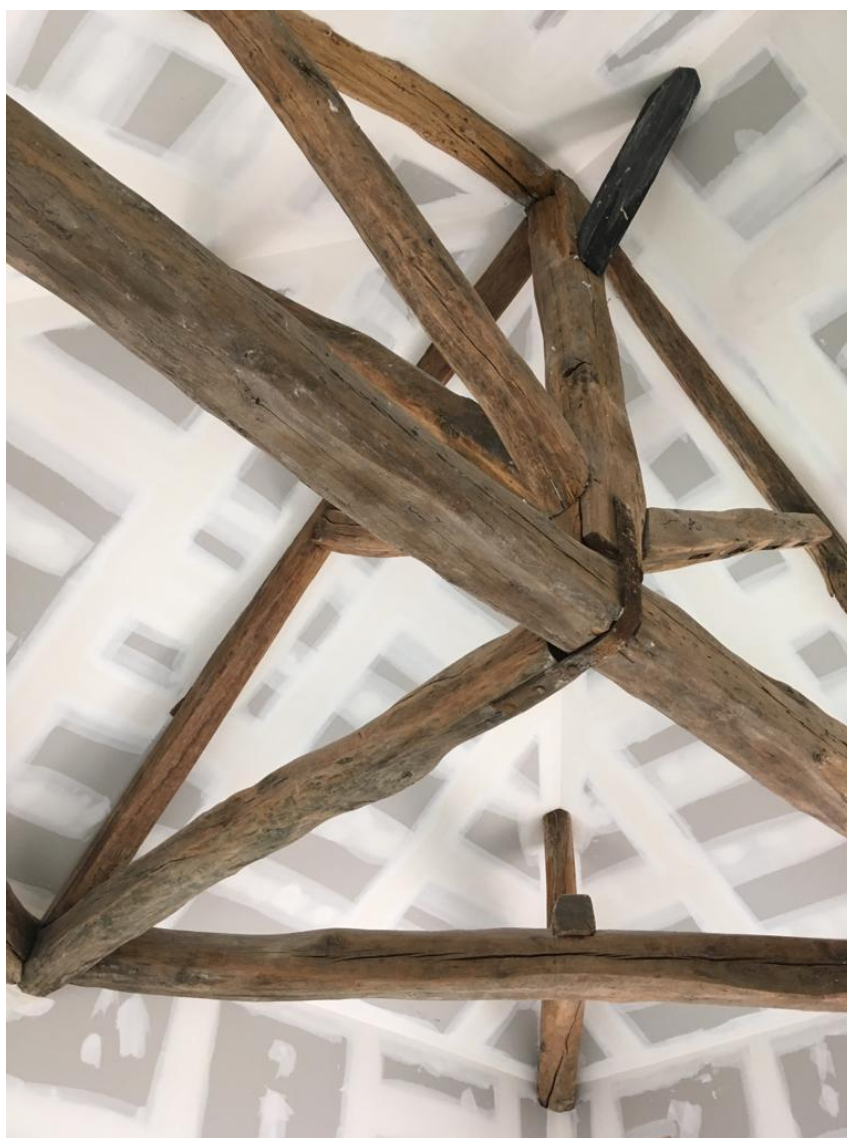
La conservation des poutres à la caserne de Reuilly
