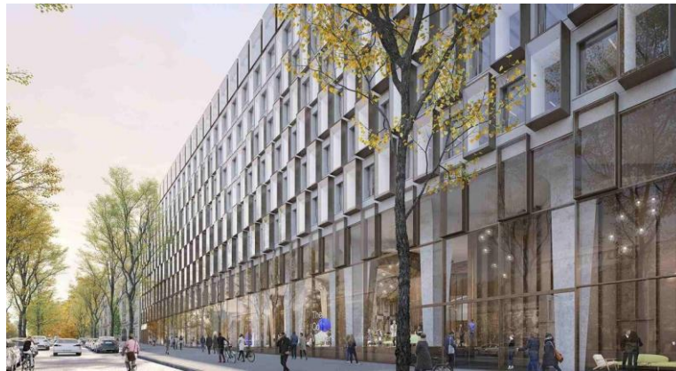
La réhabilitation du 75, avenue de la Grande-Armée
